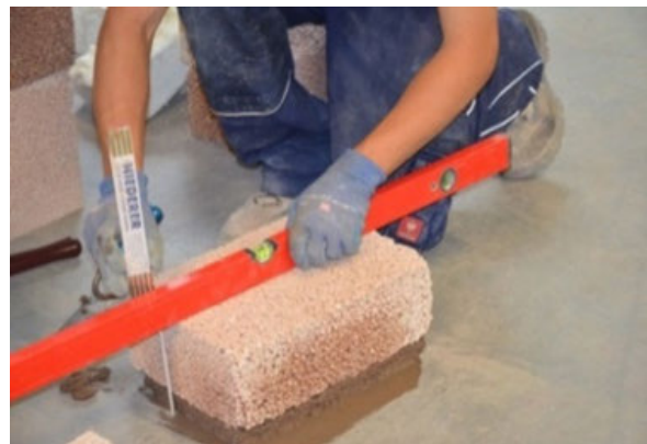
Ausrichten des Kimmsteins
