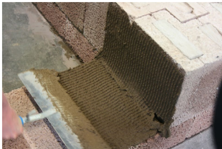
Vollflächiger Auftrag in der Wand-Ecke
